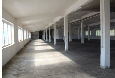
Lagerhallen im OG
